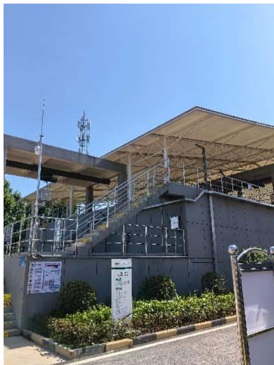
提升泵站及高效沉淀池
