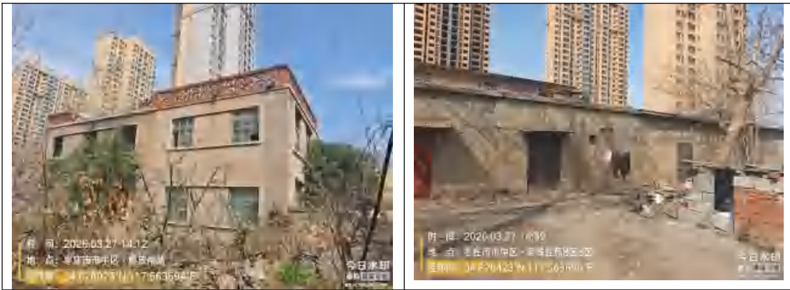
图 5.2-1 现场踏勘情况
