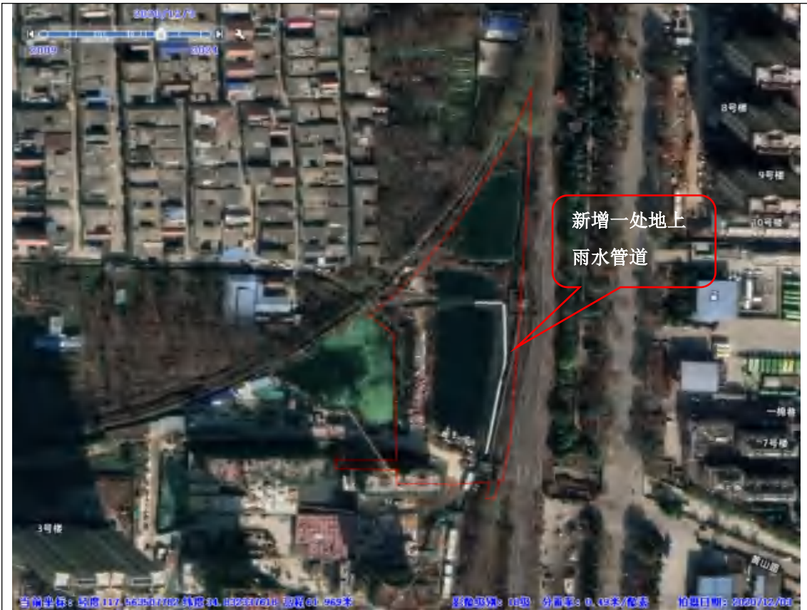
2020 年 12 月，地块内使用状况仍为两处坑塘，活动板房已拆除，新增一处地上雨水管道。
