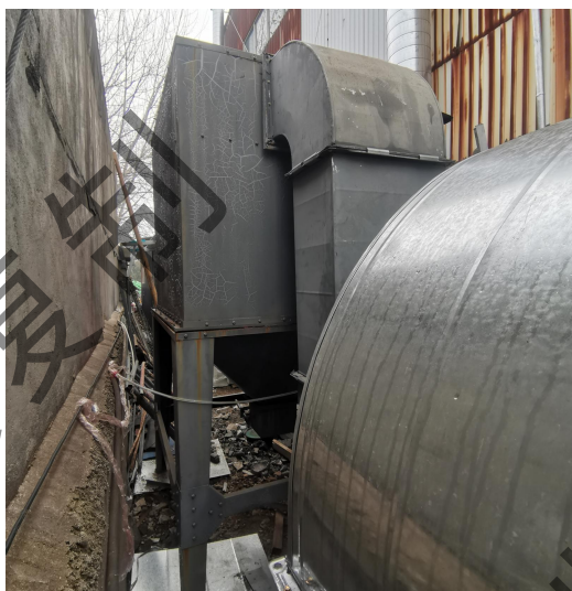
滤芯除尘器+袋式除尘器
