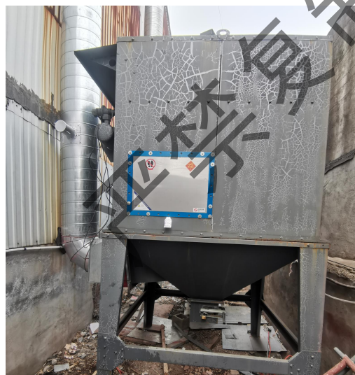
滤芯除尘器+袋式除尘器
